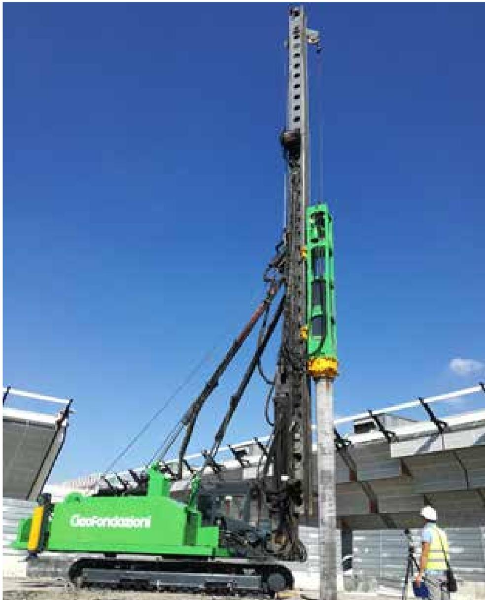
della velocità di vibrazione, effettuate in prossimità dei piani di fondazione dei fabbricati eventualmente interessati, e definire quella regolazione efficace ai fini dell'infissione che ne minimizza la vibrazione registrata.
