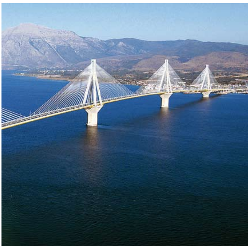
Il ‘Rion-Antirion’ un ponte sospeso in Grecia è una struttura garantita per una vita di servizio lunga. Il ponte è lungo 3 km e la campata centrale è lunga 560 m.
