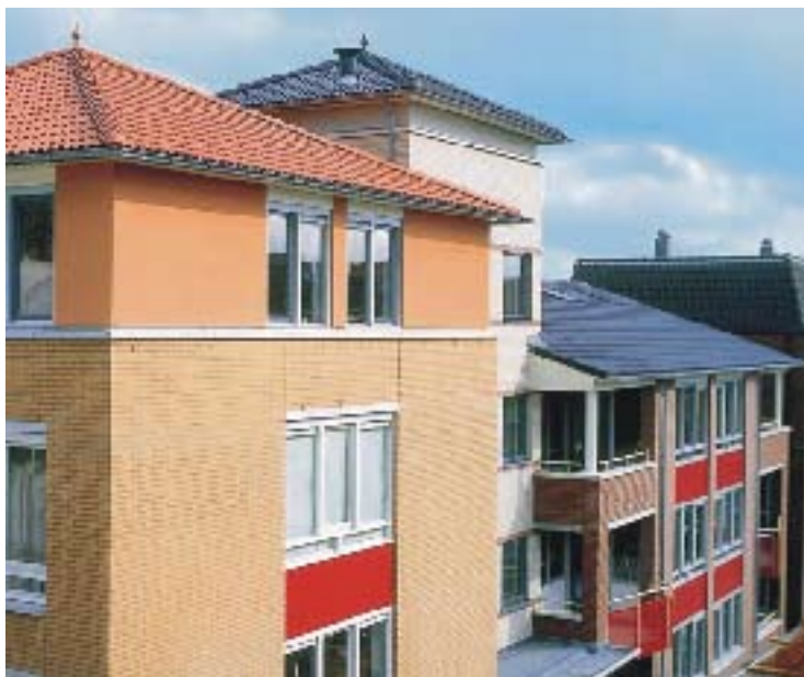
Edificio realizzato in Olanda con unità di calcestruzzo prefabbricate. Le tegole di calcestruzzo utilizzate per le rifiniture del tetto, assicurano una lunga vita di servizio all'edificio. Per gentile concessione di BFBN.
