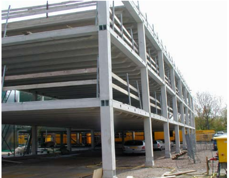
Lo scheletro di un edificio smontabile in Olanda. Per gentile concessione di BFBN.
